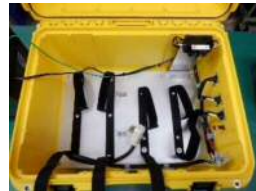
トランス取出し時
