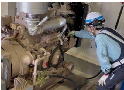
施設点検業務①
